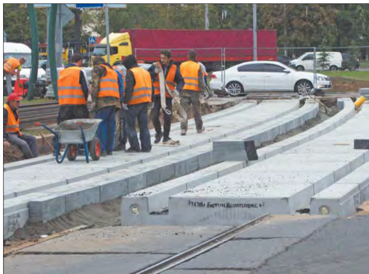
Закінчення реконструкції переїзду через трамвайні колії на перетині вул. Зої Гайдай та вул. Героїв Дніпра і відновлення руху трамвайного маршруту № 16 відбудеться до 15 вересня.
